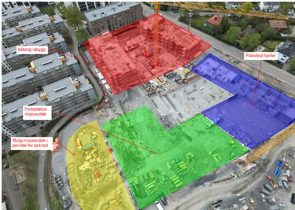
Oversiktsbilde av byggeplassen, datert 15.05.23, med markert soneinndeling av pågående arbeider
