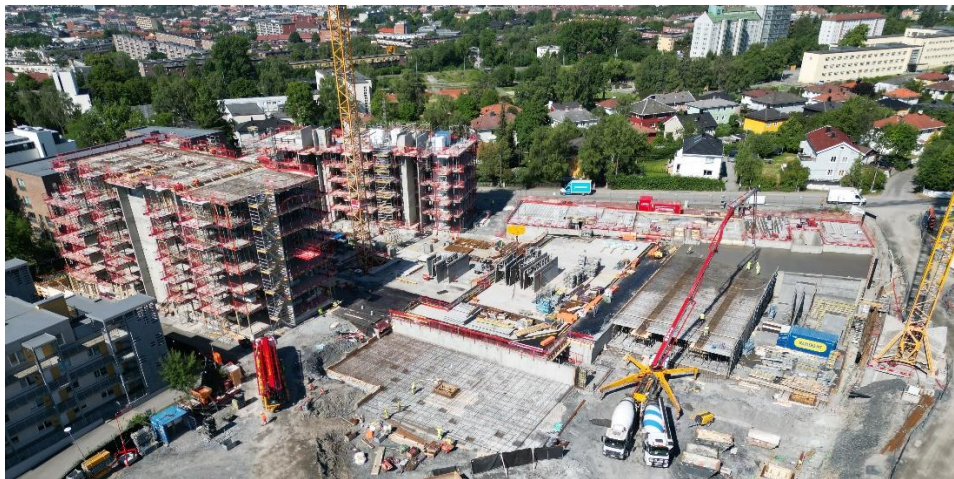
Oversiktsbilde av byggeplassen, datert 28.06.2023
