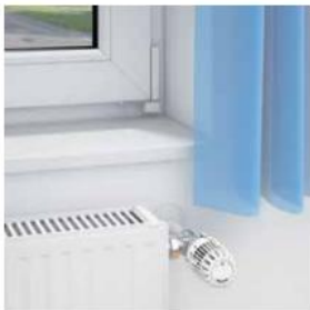
Korrekt Luft sirkulerer fritt rundt termostathodet.
